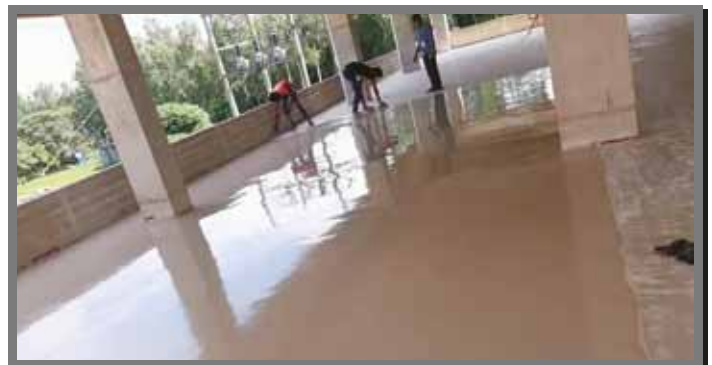
Fig- PU Flooring using ShaliFloor PU
